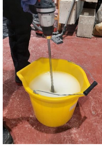
(d) Mixing Sikadur 300 adhesive material
